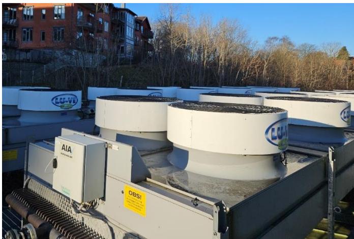
Figur 1: Ljuddämpare, vita cylindrar, monterade kring varje fläkt på K12.
